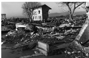
1959, rupture du barrage de Malpasset
