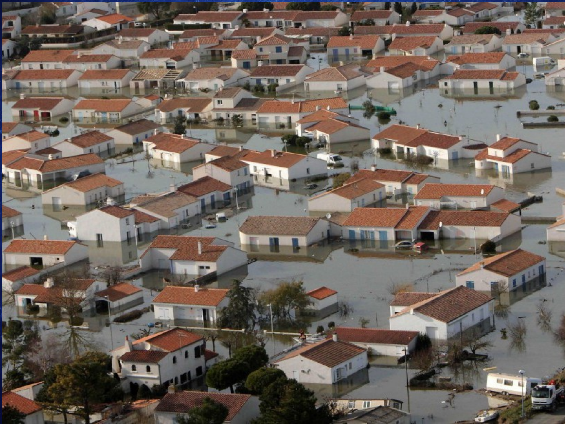
La commune de la Faute-sur-Mer envahie par la mer après la rupture des digues, 29 morts
