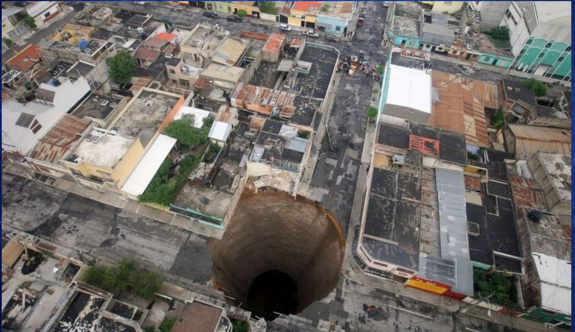
Gouffre géant de 40 mètres de diamètres et de 60 mètres de profondeur formé au cœur de Guatemala city, 2010
