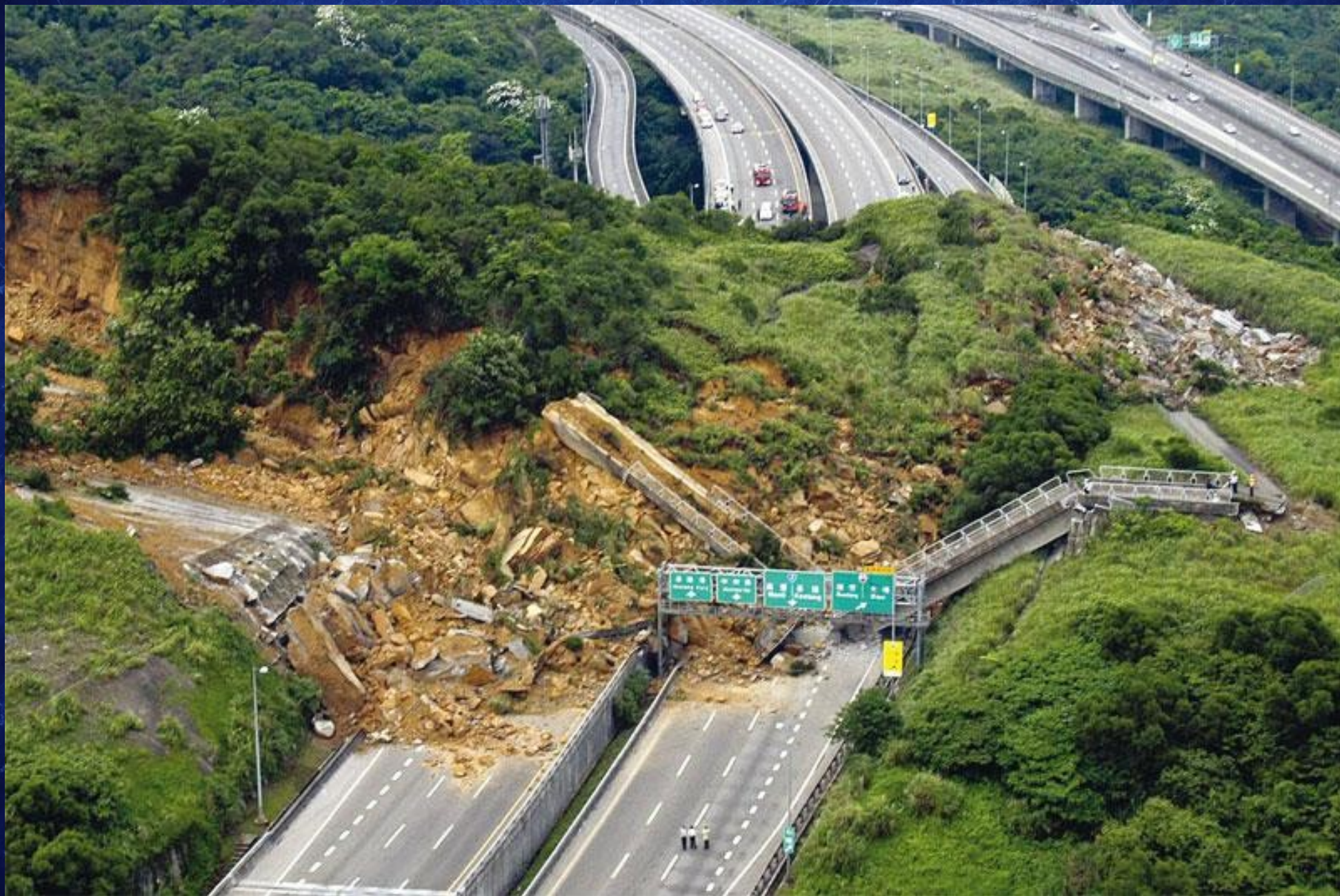
Glissement de terrain à Taïwan sur l'autoroute Formosa n°3 reliant Taipei à Keelung, 4 morts
