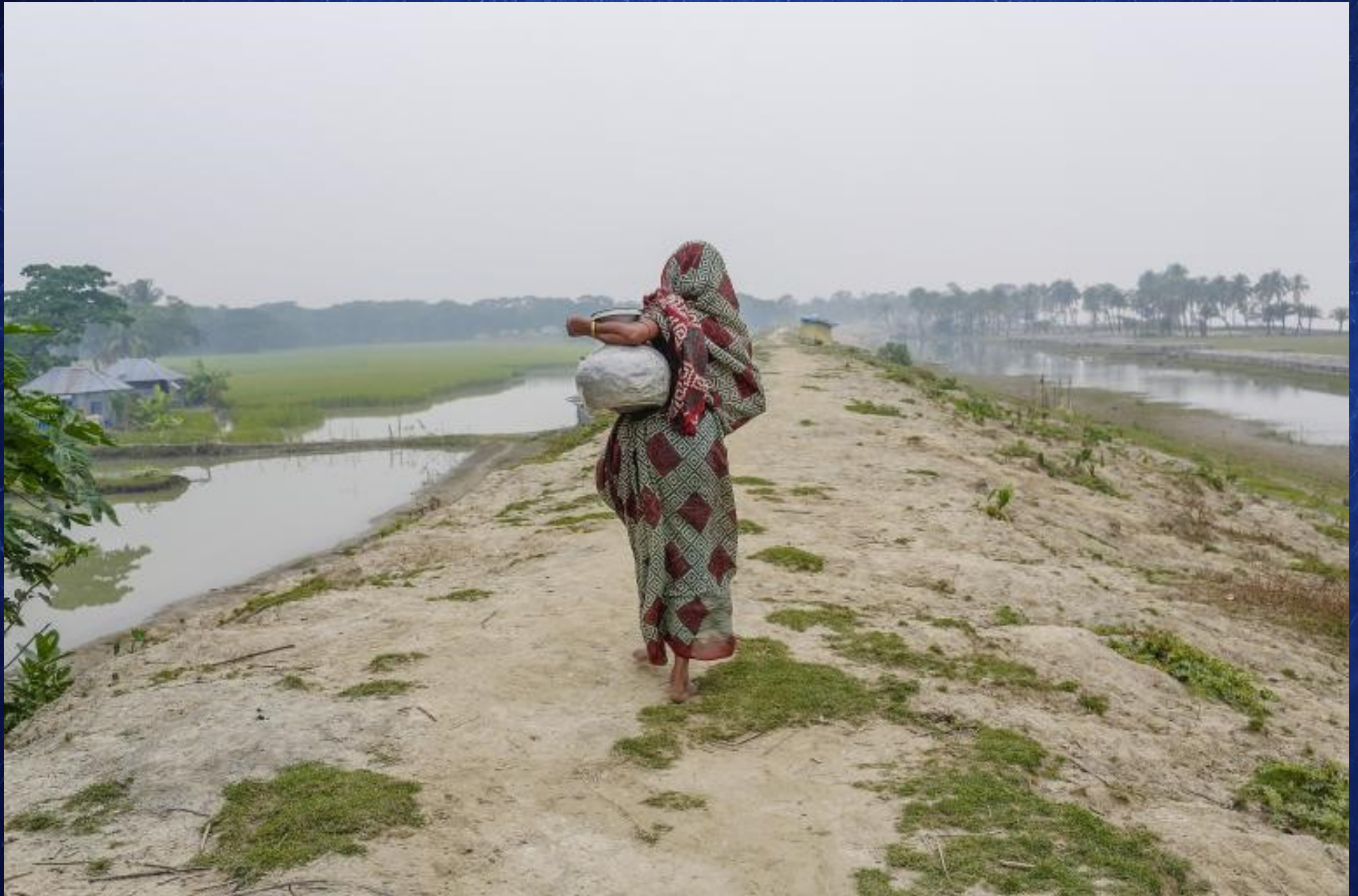
Une digue en terre
