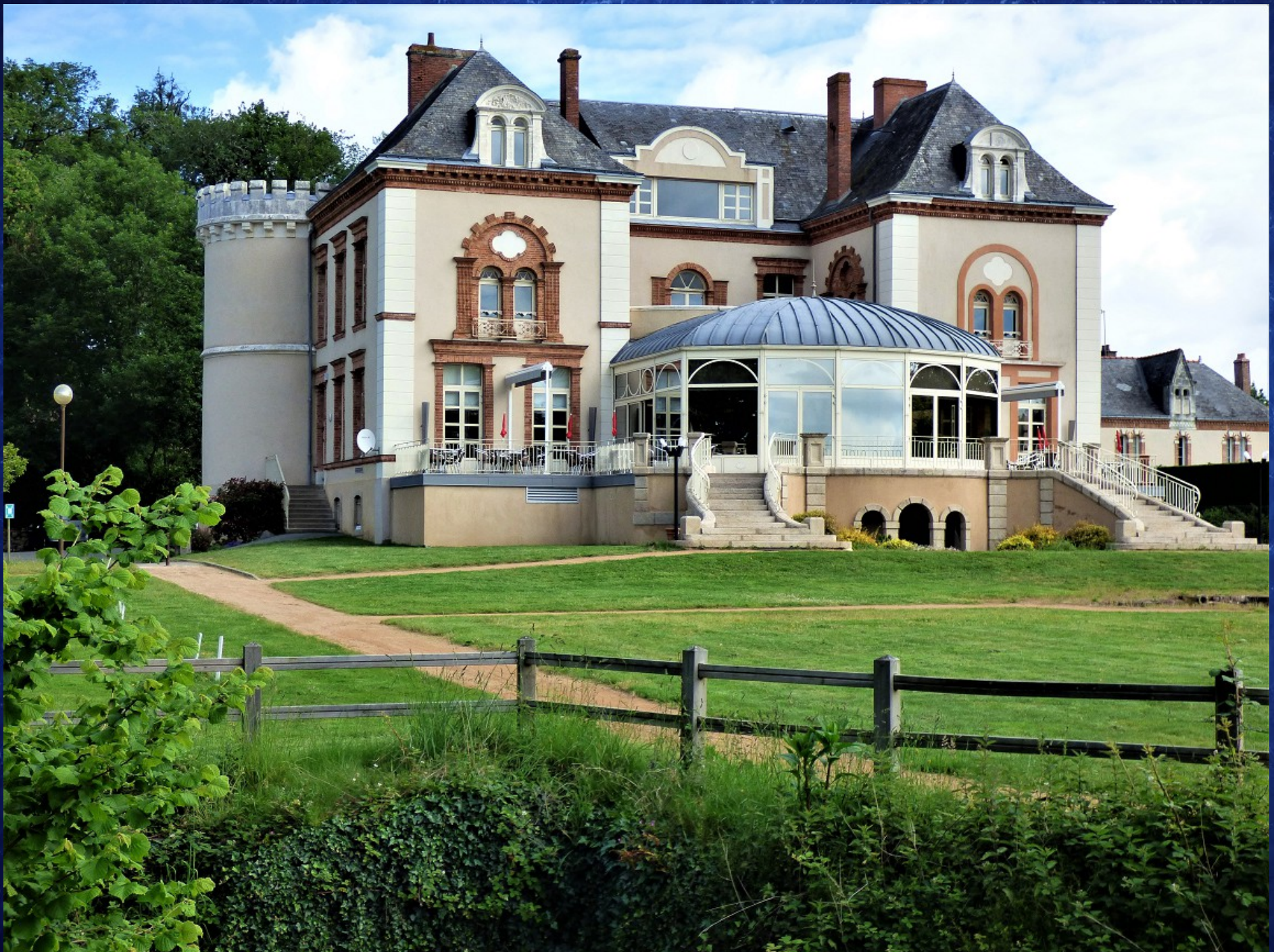
Château du golf, allée du Chêne Landry
