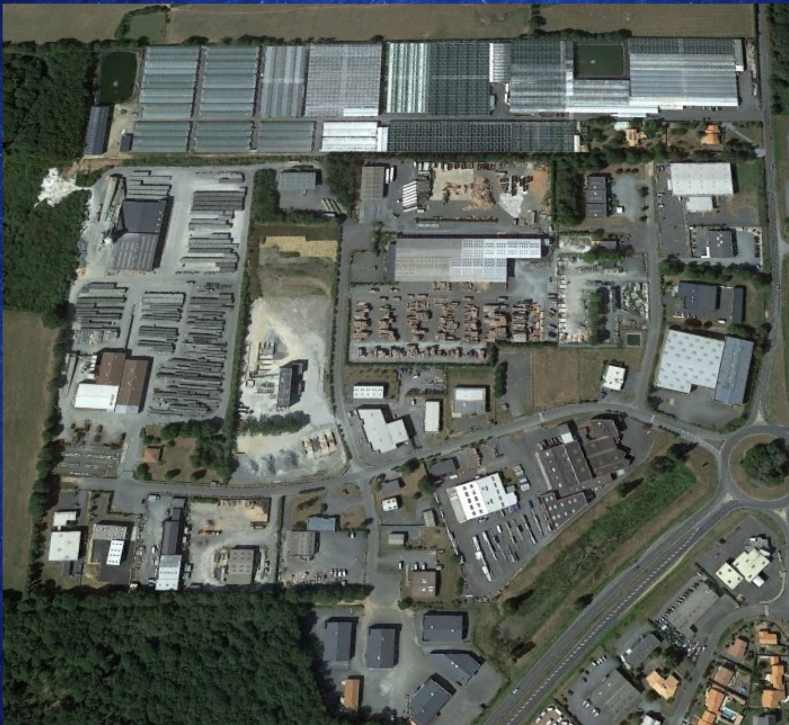
Zone industrielle des Grands Bois à la Séguinière
